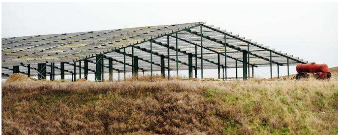
Von der geplanten Legehennenanlage Zollchow II in der Uckermark in Brandenburg steht nur der Rohbau. FOTO: KITTY KLEIST-HEINRICH
